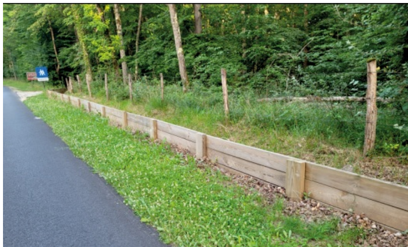
Barrière de protection le long d'une route
